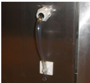
Figur 5. Montering av tryckslang för mätning av atmosfärstrycket.
